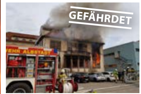
Villa Maag, Albstadt (BW): Brand durch Brandstiftung im Mai 2021, verliert Denkmalschutz, Anfang 20. Jh., Baustil: Jugendstil, Besonderheit: ehem. Familiensitz des Textilfabrikanten F. Maag, Abriss in Planung
