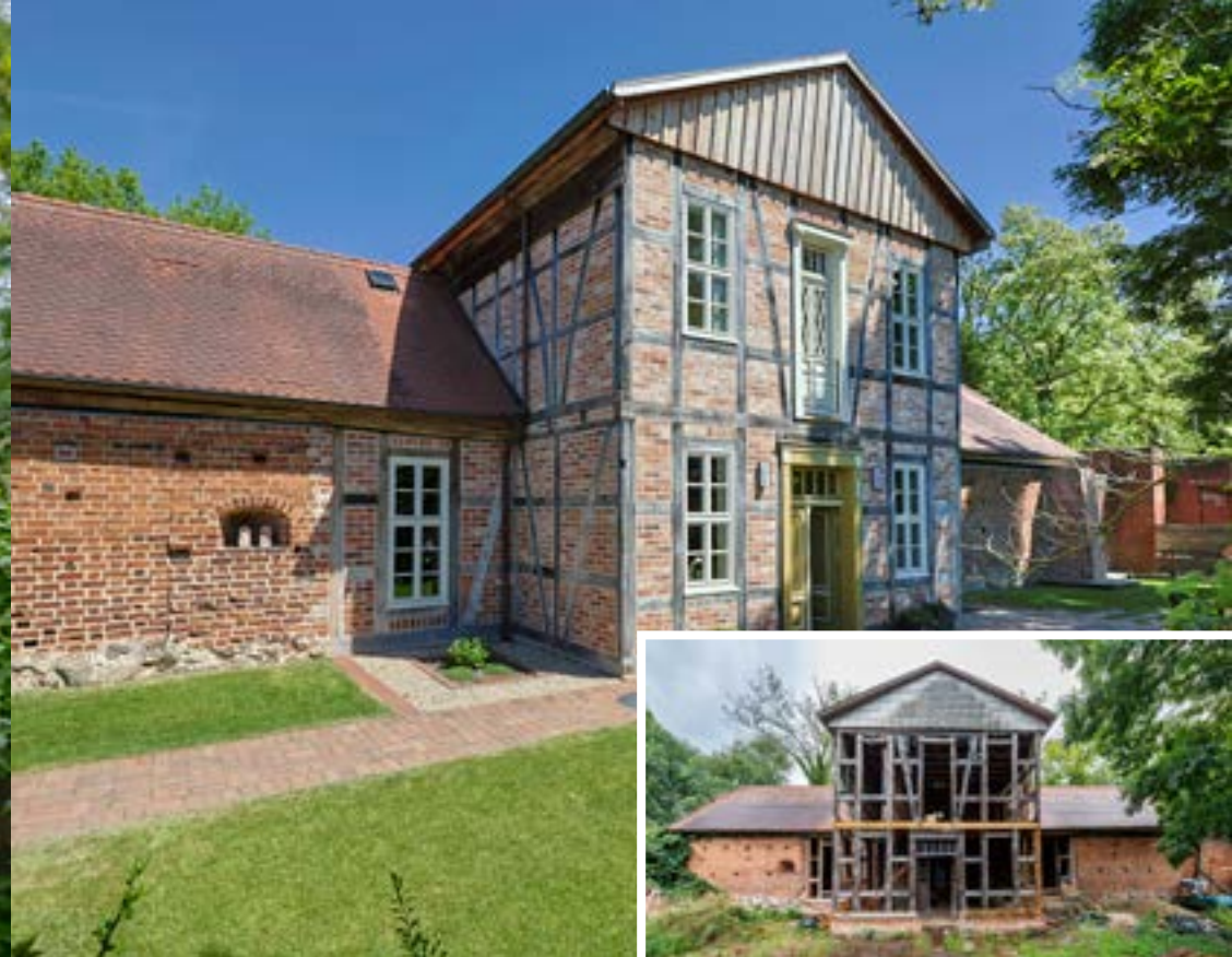
Die Fachwerkfassade wurde wieder instand gesetzt, nachdem die Gefache viele Jahre zuvor entfernt worden waren. Links und rechts davon lässt sich die in das Gebäude integrierte Stadtmauer erkennen
