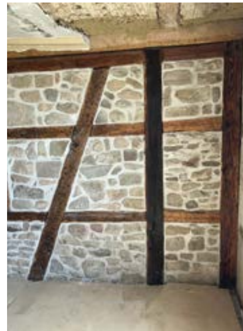
Eine sanierte Fachwerkwand ist mit Steinen ausgefacht
