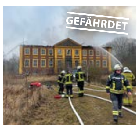
Schloss Johannstorf, Dassow (MV): Brand im März 2025, 1743, Baustil: Barock, Rettung auch durch die Deutsche Stiftung Denkmalschutz läuft
