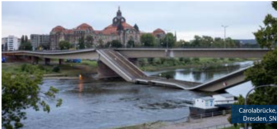
Ganz Deutschland sprach über den plötzlichen Zusammenbruch der Carolabrücke. Ein Paradebeispiel für den Sanierungsstau.
