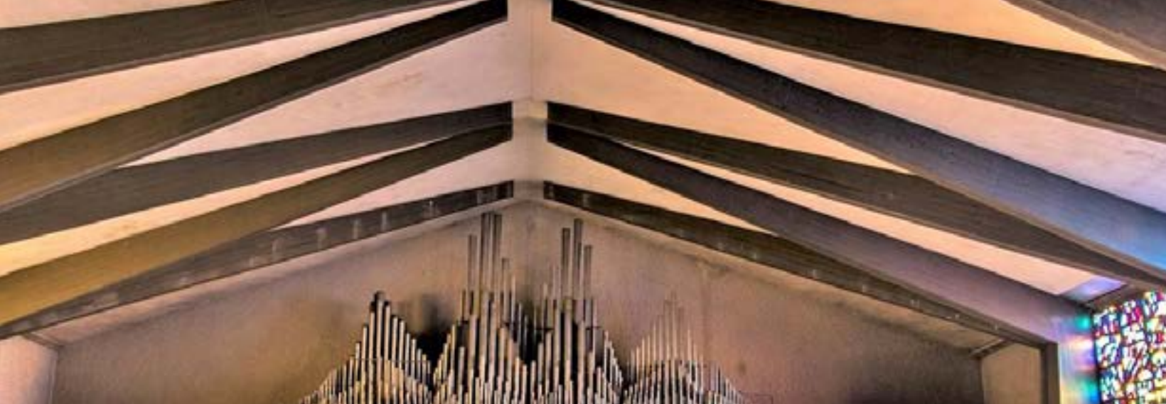
Auch die beeindruckende Deckenkonstruktion ist etwas ganz Besonderes
