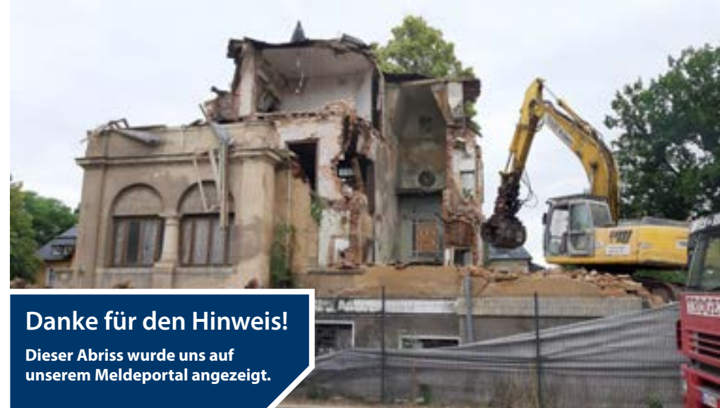
Im Frühjahr 2025 wurde die Ulrich-Villa abgerissen
