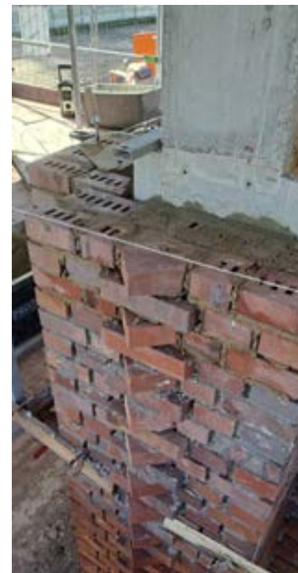
Dank der Entscheidung für den denkmalgerechten Erhalt wurden die Säulen wieder mit Backsteinen im Originalformat aufgemauert
