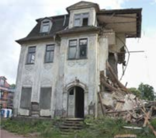
Der Abriss der Hohen Sonne erfolgte im Mai 2025
