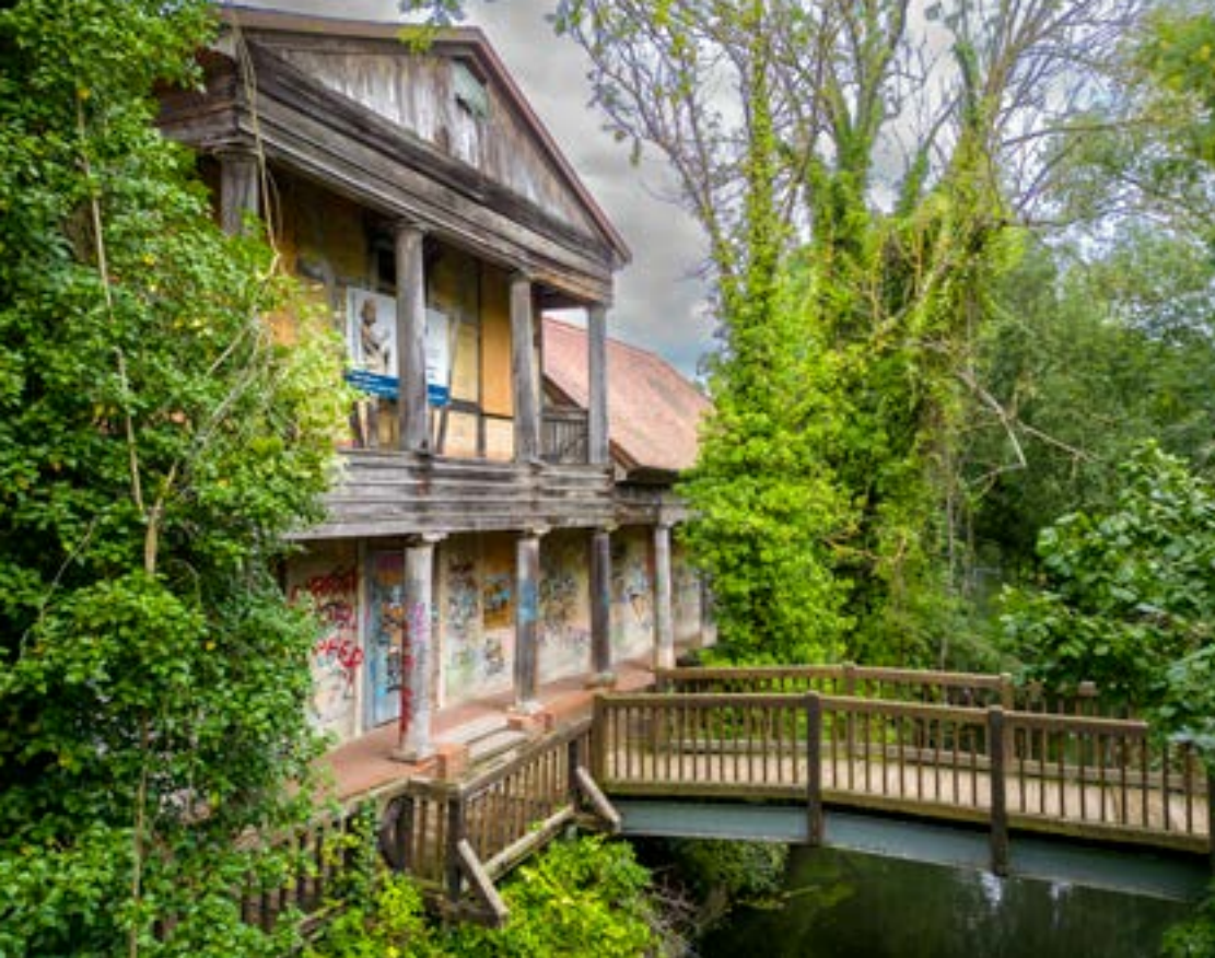
Die bestechende Eleganz der klassizistischen Fassade mit Säulengang ließ sich auch im stark sanierungsbedürftigen Zustand noch erkennen
