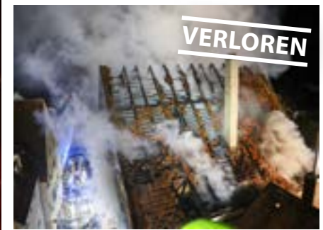
Fachwerkhaus, Riedlingen (BW): Brand im Januar 2025 mit zwei Toten, 2. H. d. 16. Jh., Besonderheit: repräsentatives Fachwerkhaus, historische Stadtmauer aus dem 14. Jh., Abriss 2025
