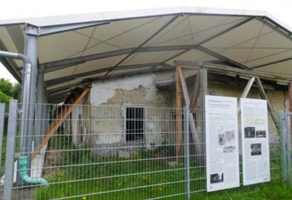
Die Gefangenensbaracke ist mit einem Wetterschutzdach und Abstützungen gesichert. Bundesweit gibt es keine so gut erhaltene Kriegsgefangenenbaracke aus der Zeit mehr
