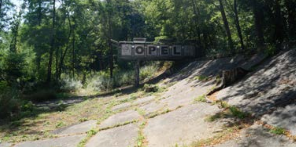
Die Schrägrennstrecke aus Beton war damals eine absolute technische Sensation. Heute ist das Denkmal durch Bewuchs angegriffen und fast unkenntlich
