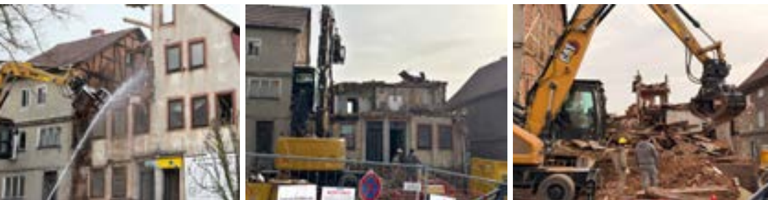
Mit dem Abriss des ehemaligen Frauenhauses ging das Zeugnis einer außergewöhnlichen sozialen Leistung der Stadt für immer verloren
