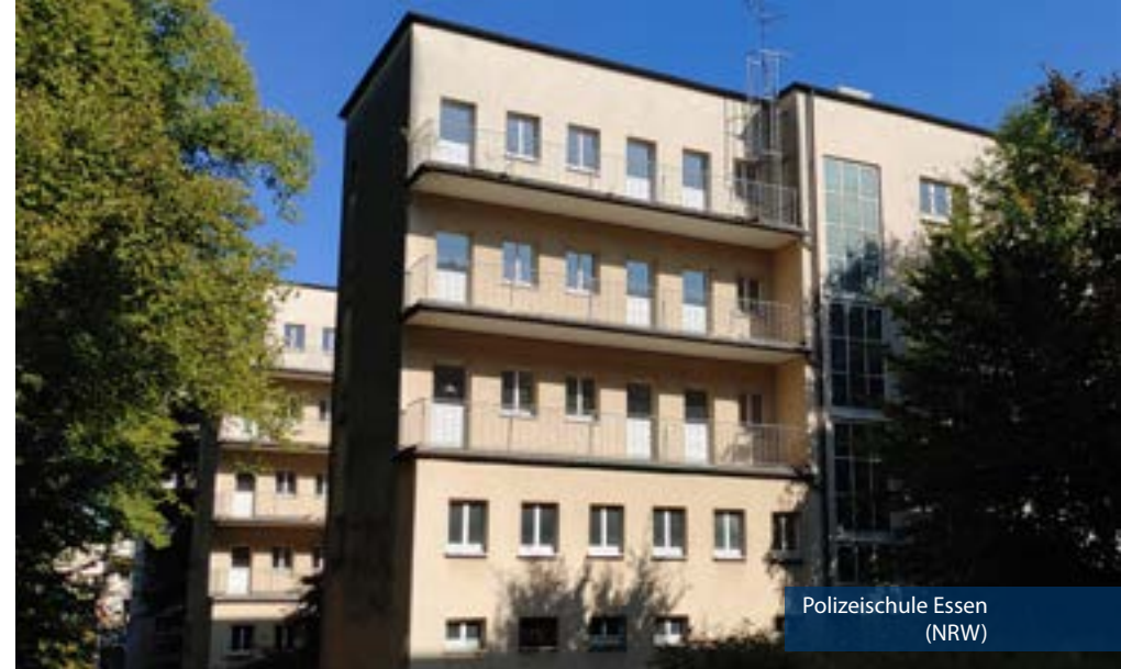
Ein Bauhaus-Denkmal der 1930er Jahre, heute ein verlassener Riese, der seit Jahrzehnten verfällt
