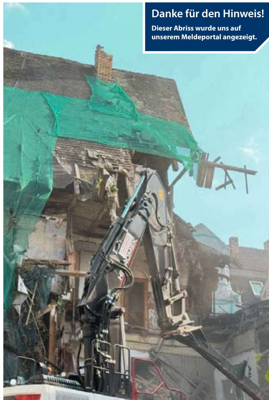
Im September 2025 wurden Dachstuhl und Fachwerkgeschosse des Renaissance-Hauses abgerissen
