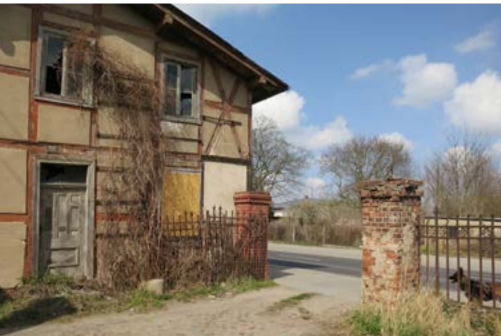
Der Innenhof mit Palmenhaus, umringt von einer historischen Einfriedungsmauer, ist noch erhalten
