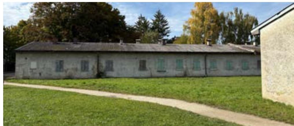
Im Juli 2025 wurde der Antrag für den Abriss der Wachmannschaftsbaracken zurückgezogen
