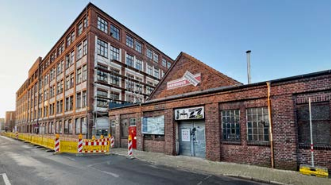
Die kleinen Knecht'schen Hallen mit Kranhaus und Mantelhalle waren einst Teil einer Lederfabrik
