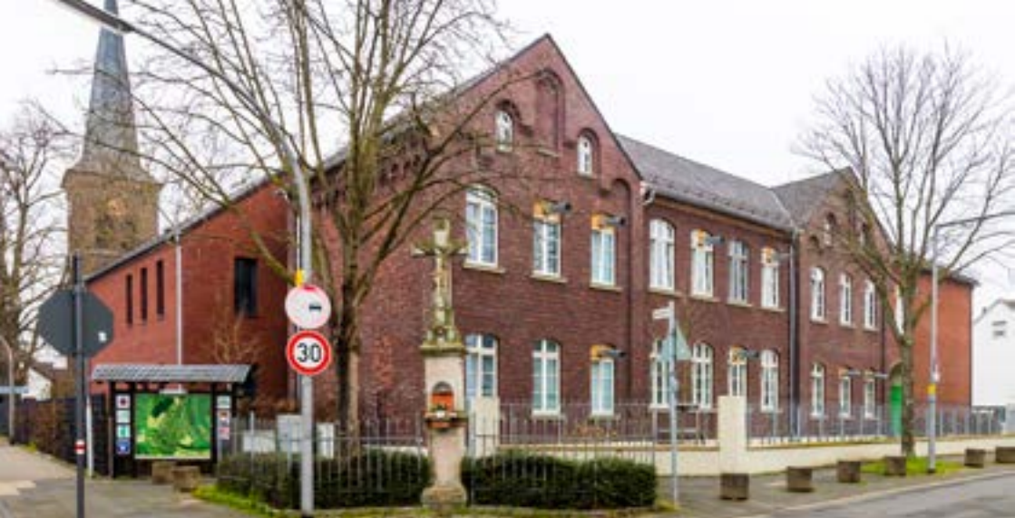
An den Fenstern wurden Entlüftungsrohre angebracht, um die Schadstoffe abzuleiten, die durch eine fehlerhafte Fassadenbehandlung entstanden sind
