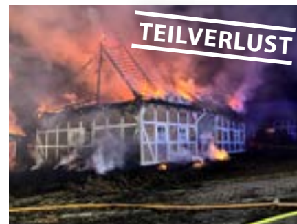
Drei Reetdachhäuser, Dollern (NI): Brand im März 2025, Ende 18. Jh., Besonderheit: Teil eines Ensembles von Hofanlagen des historischen Siedlungskerns nach Brand 1793, Scheune wird abgerissen
