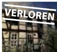
Gasthaus Blumenau, Wunstorf (NI): Brand im August 2022, 1806, Baustil: zeittypisch, einzelne Bauteile gesichert, Abriss 2024
