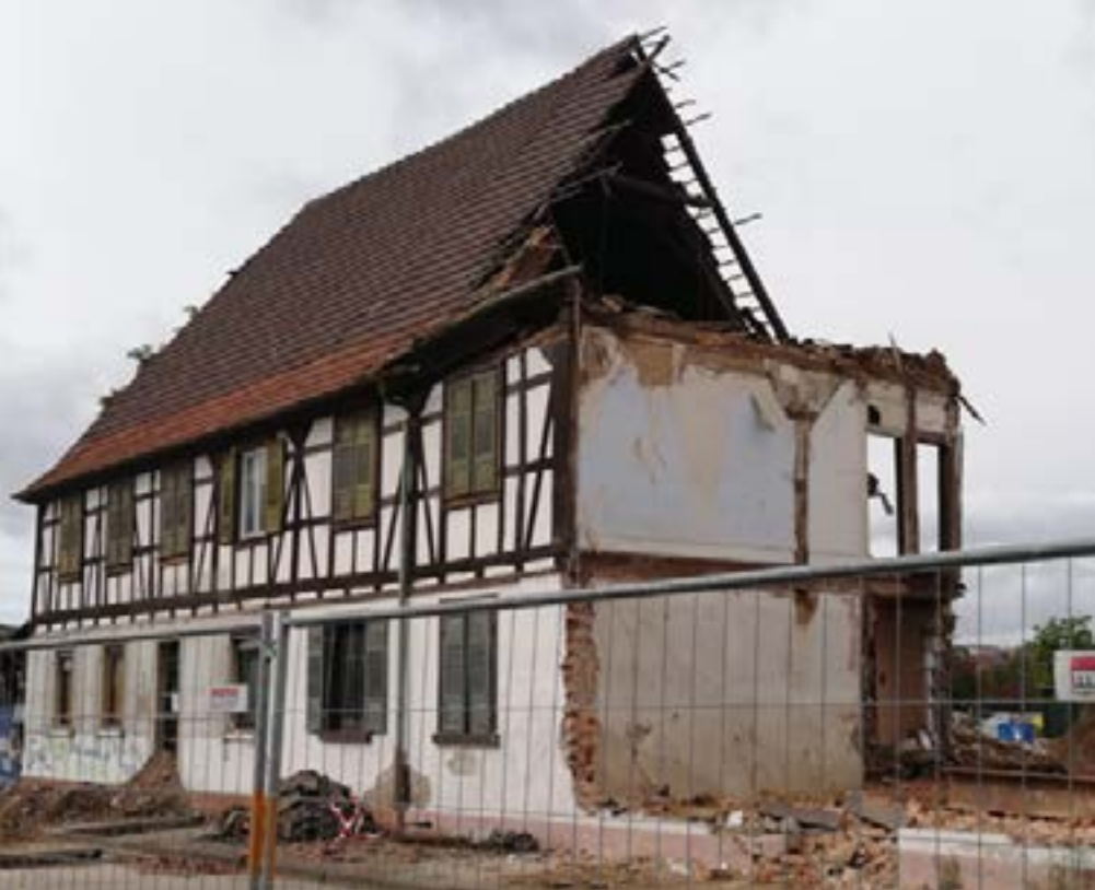
Nur drei Tage lagen zwischen der Mitteilung, dass das Gebäude nicht zu erhalten sei, und dem Abrissbeginn
